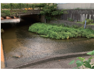
国道2号線北側／川幅が急に狭くなる馬路川
